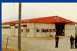
竣工時の帯広工場
