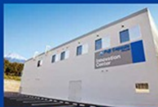
竣工時のイノベーションセンター
