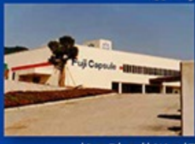
竣工時の芝川工場
