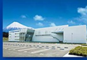
竣工時の北山工場
